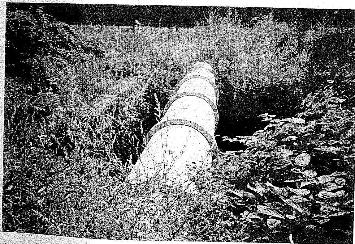
Foto 018 – Rio intubato TAMOCA002 che passa sul canale TAMOCA001
