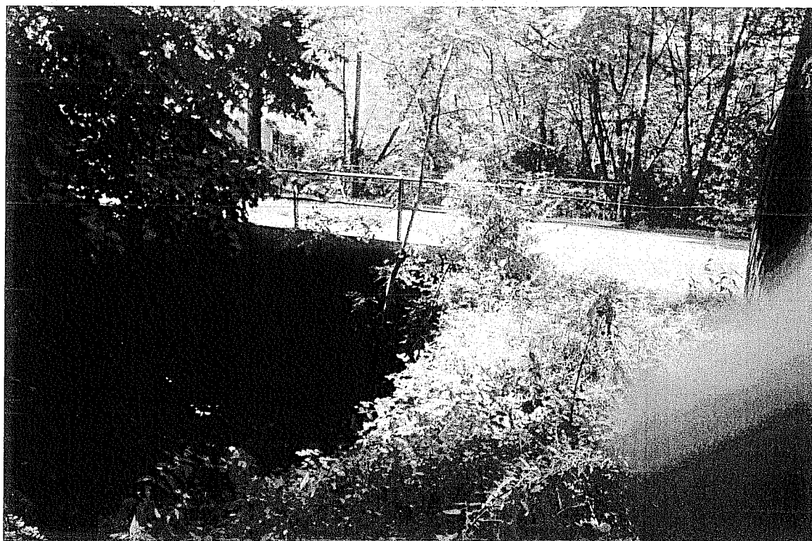
Foto 033 – Ponte TAMOPO023 sul Rialone a C.Arvestio
