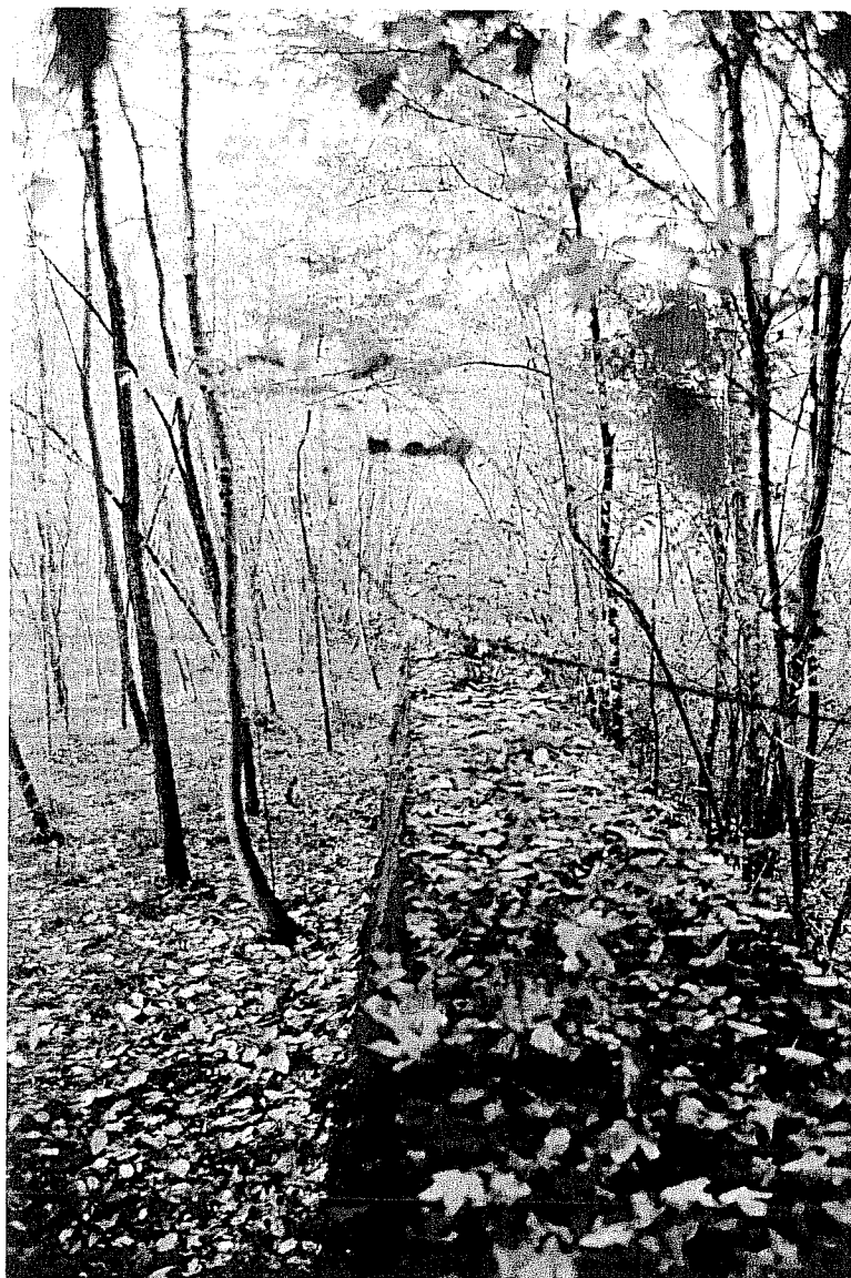
Foto 045 – Vista argine TAMOAR001 in zona D1
