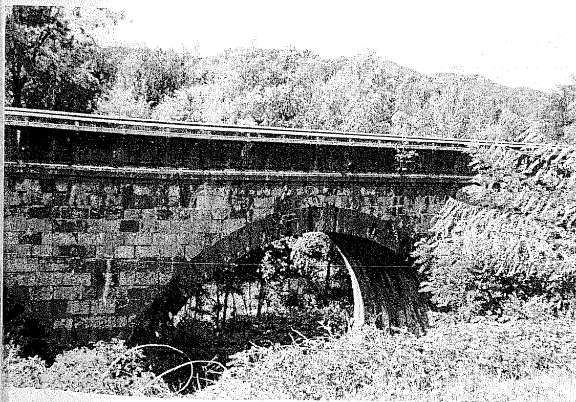
Foto 008 – Ponte ferroviario TAMOPO002 su rio S. Quirico
