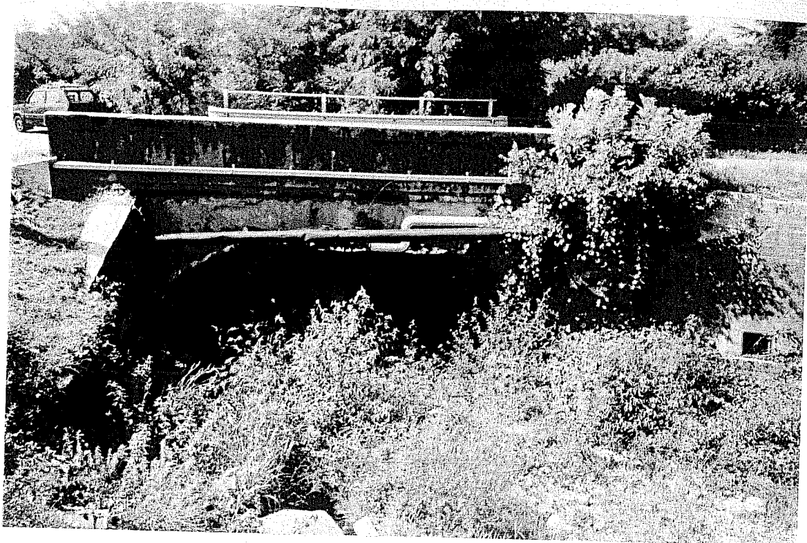
Foto 025 – Ponte sul torrente Mologna TAMOPO017 sulla S.P.
