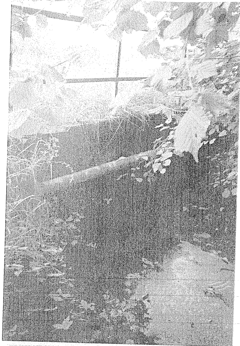
Foto 039 – Sbocco della tombinatura TAMOCA005 in zona S.Rocco
