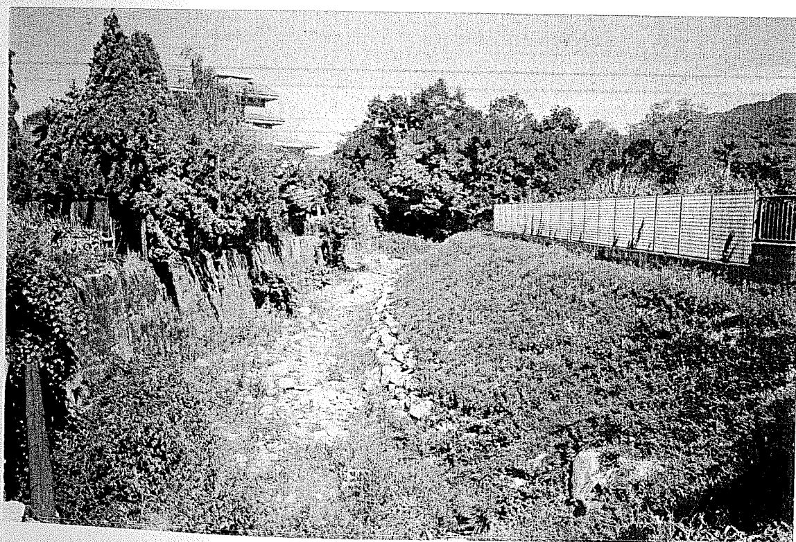
Foto 024 – Muro in cls. TAMODS009 lungo il torrente Mologna a monte del ponte AMOPO007 sulla sponda opposta scogliera TAMODS008
