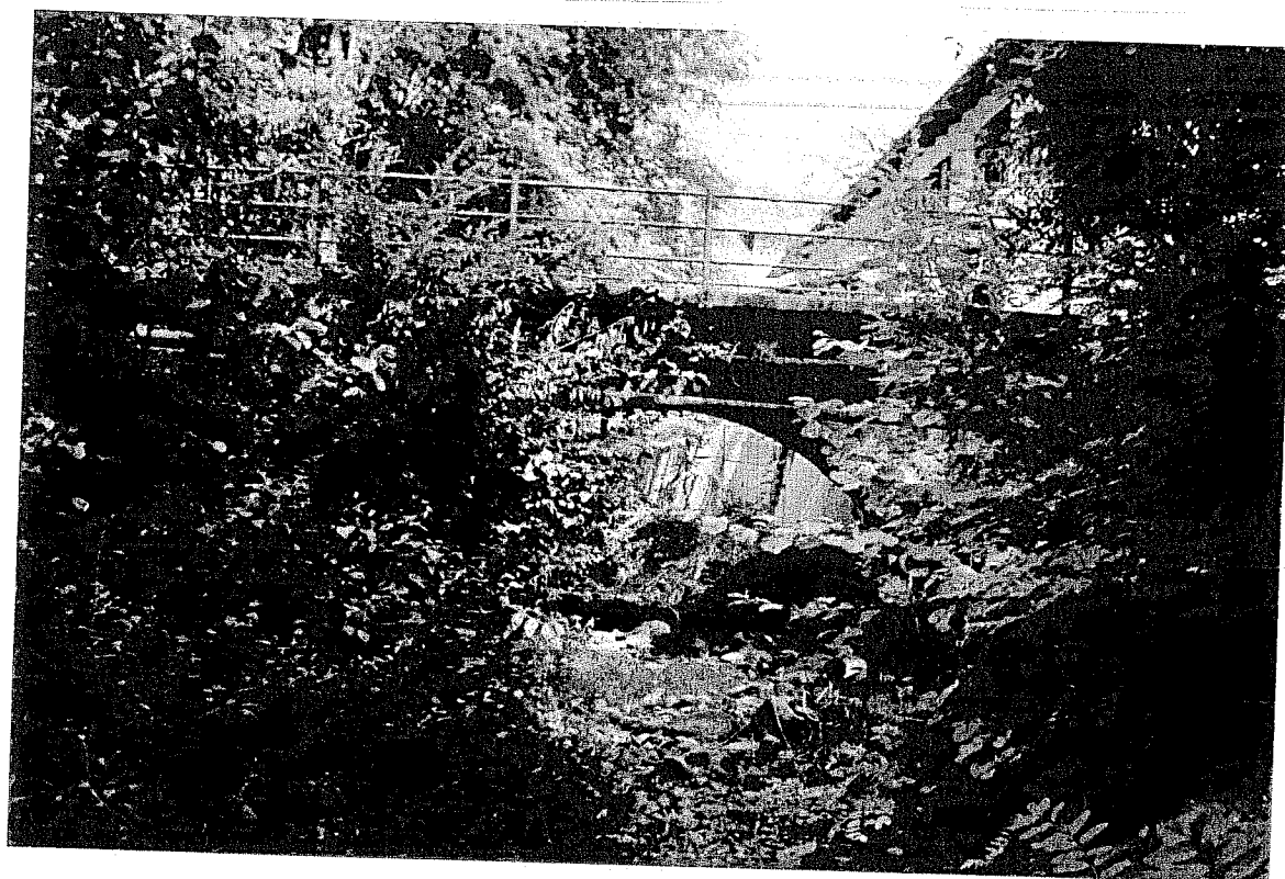
Foto 034 – Attraversamento TAMOAG014 sul torrente Mologna a Cà Negri
