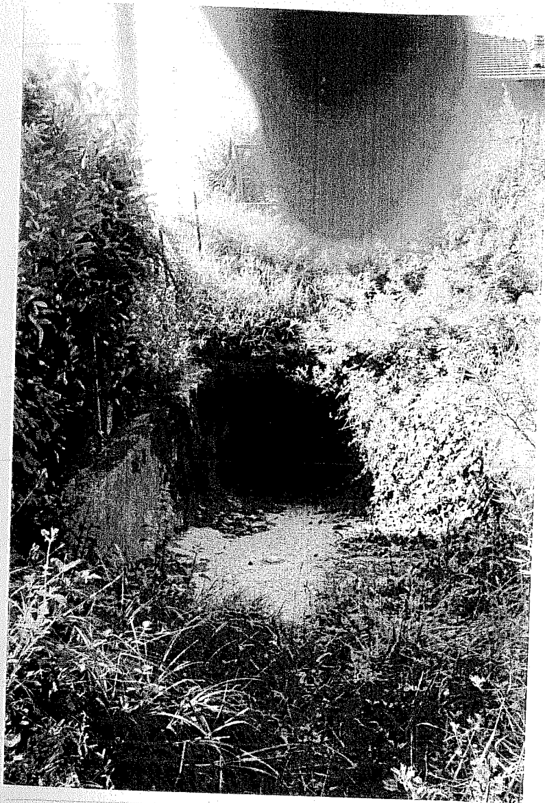
Foto 019 – Imbocco tombinatura TAMOCA002
